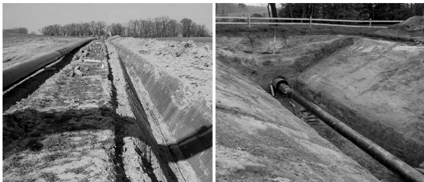
Рис. 3. Прокладка опто-волоконного кабеля по трубопроводу
